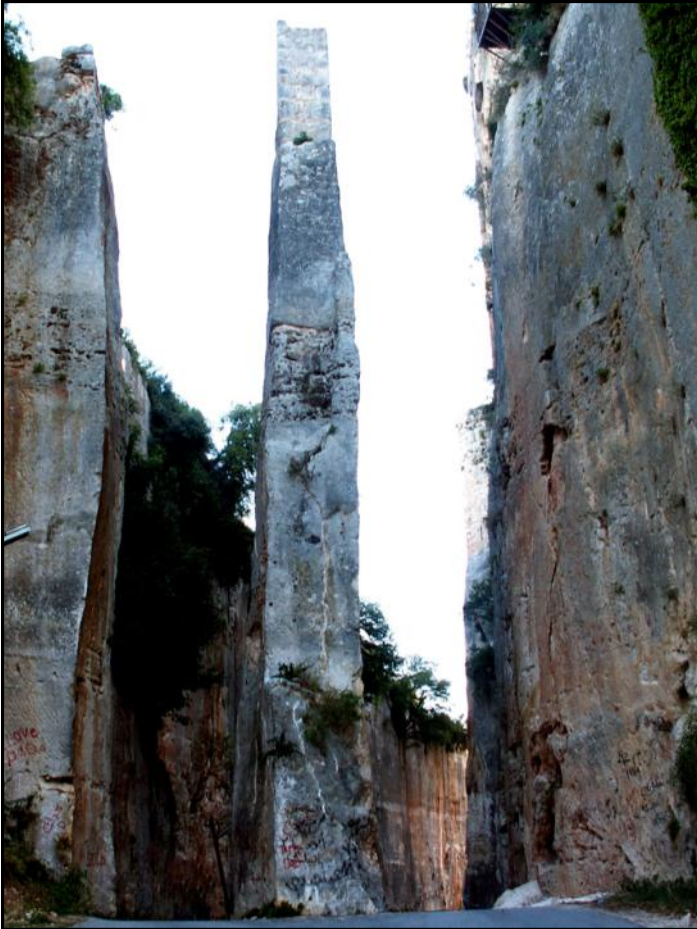
Le côté le plus spectaculaire de la forteresse est le fossé creusé dans le roc. Sa forme sous les tours montre qu'il a été creusé après que l'on ait bâtie l'enceinte est des Croisés. Le piton pour soutenir le pont levé laisse rêveur.
