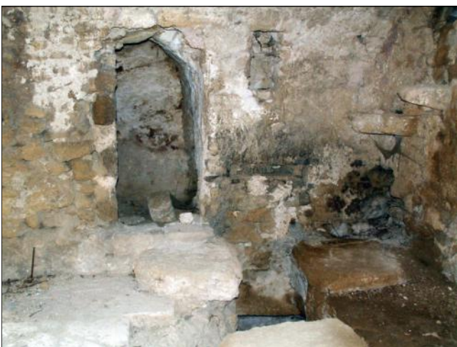
Fig. 19 : Dans la sacristie, la porte du petit réduit et à droite, l'ouverture de la citerne.
