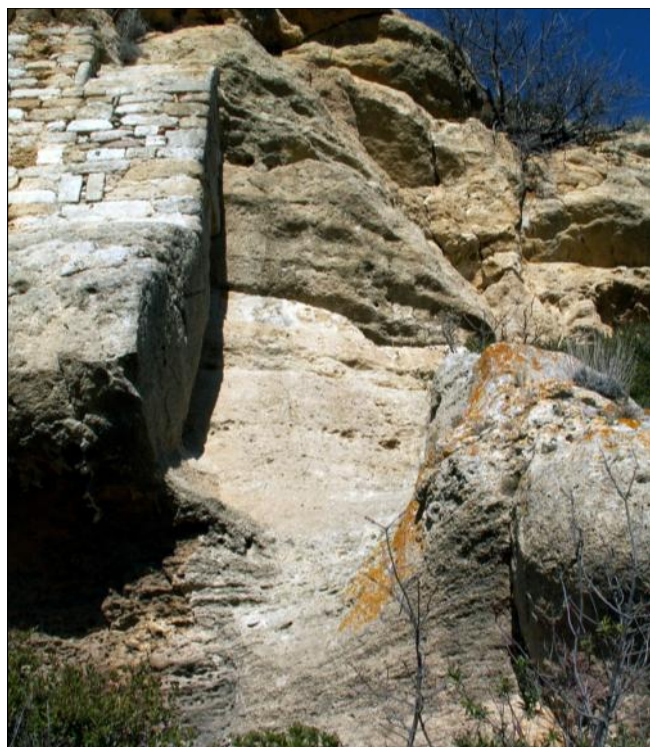
Fig. 8 : On voit comment la vire a été creusée pour interrompre l'accès à la baume.
