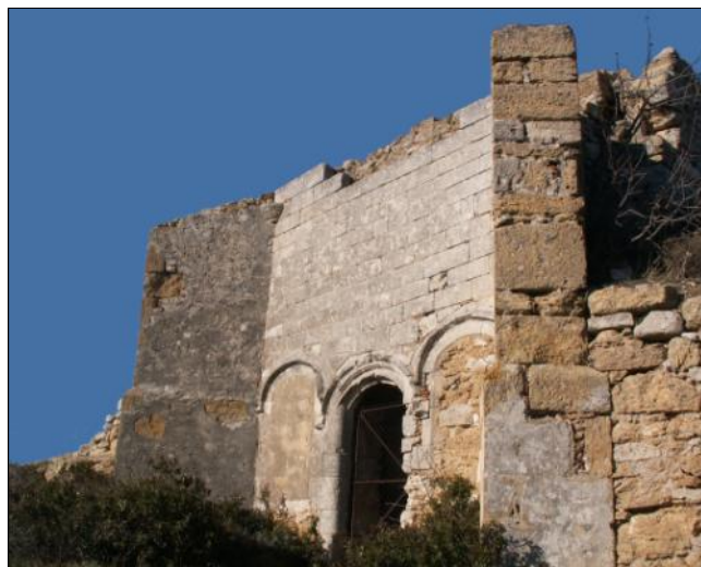
Fig. 12 : La belle façade de la chapelle. Un parement de belles pierres couvre la maçonnerie plus frustre.
