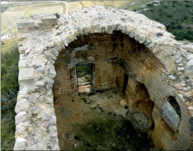
Fig. 13 : Vestiges de la voûte, dont les joints ont été refaits. A gauche, l'assise du clocheton, en bas la nef.
