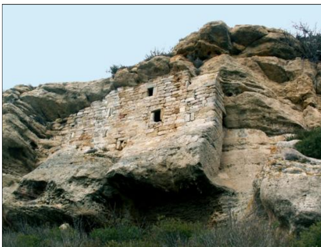
Fig. 6 : La belle façade de la baume fortifiée dont les pierres maçonnées ont bien résisté au temps.
