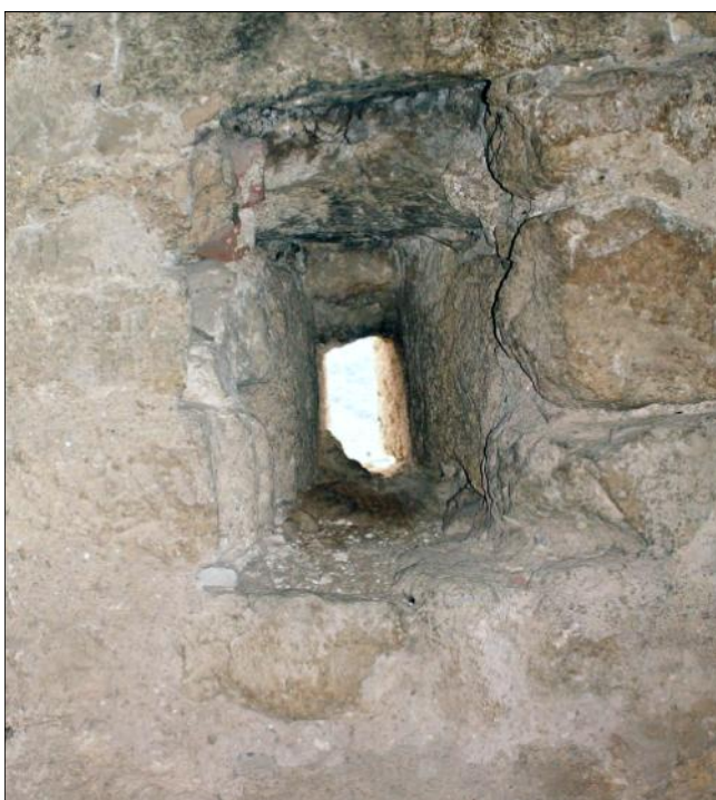
Fig. 7 : Meurtrière ou archère ? Le manque de hauteur de certaines archères génère des questions.
