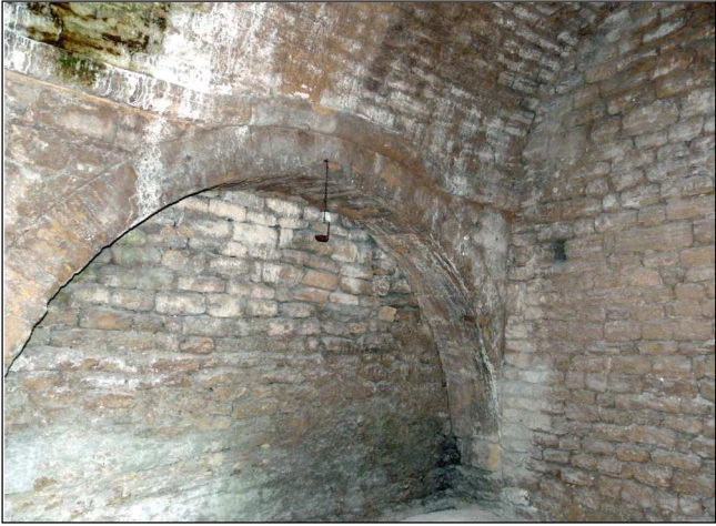
Fig. 8 : La voûte plein-cintre du mur N.O.. On voit à sa droite le mur du chevet empiétant sur son appareillage, prouvant que la salle a été raccourcie.
