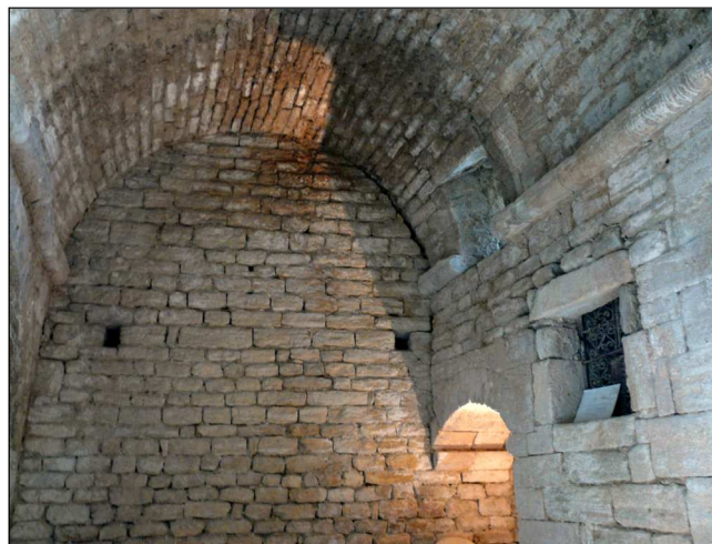
Fig. 6 : La voûte plein-cintre de la première salle repose sur deux corniches. Au fond à droite, le «placard».
