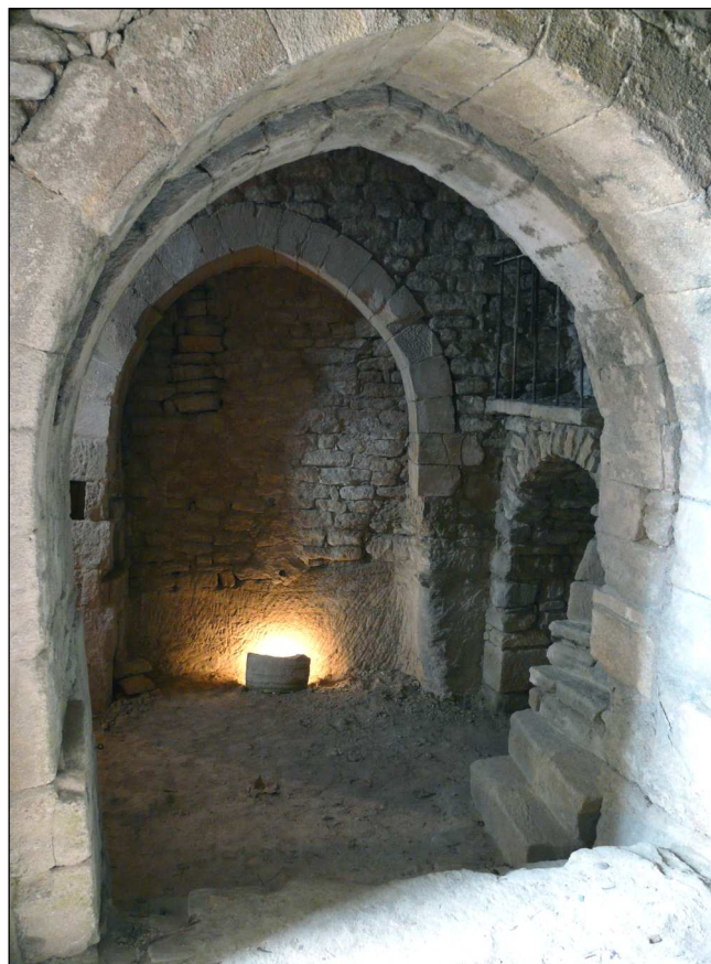
Fig. 12 : Cette image éclaire plusieurs points : on y voit bien le hiatus inégal de la porte séparant les deux salles. Au fond, on voit le faible creusement dans la roche encaissante (1 m) et à droite, on voit l'escalier accédant au deuxième niveau de cave donnant sur la salle 2.
