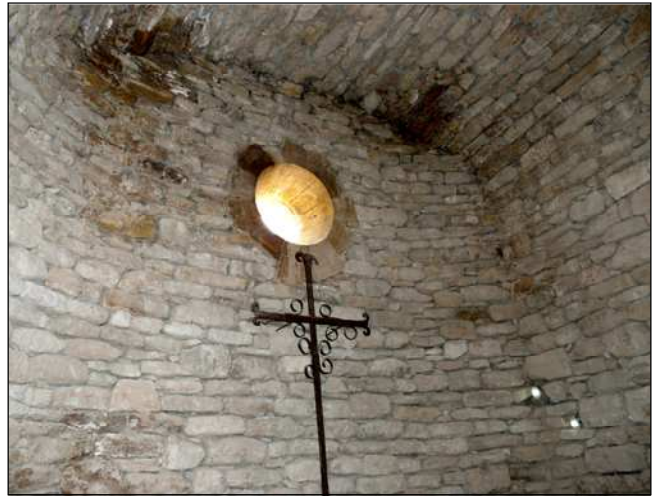
Fig. 10 : Le chevet et la voûte de la salle 2 ont été refaits. Au dessus de la voûte, la première des terrasses aménagées sur la pente de l'éperon de Gordes.
