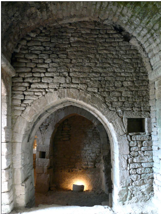
Fig. 9 : La porte séparant les salles 1 et 2. On distingue le hiatus entre son double appareillage. Hiatus de 13cm à gauche qui diminue à 1 cm à droite.
