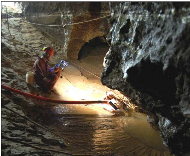
Photos du haut : acheminement des tuyaux dans la grotte et installation de la pompe au siphon 1
