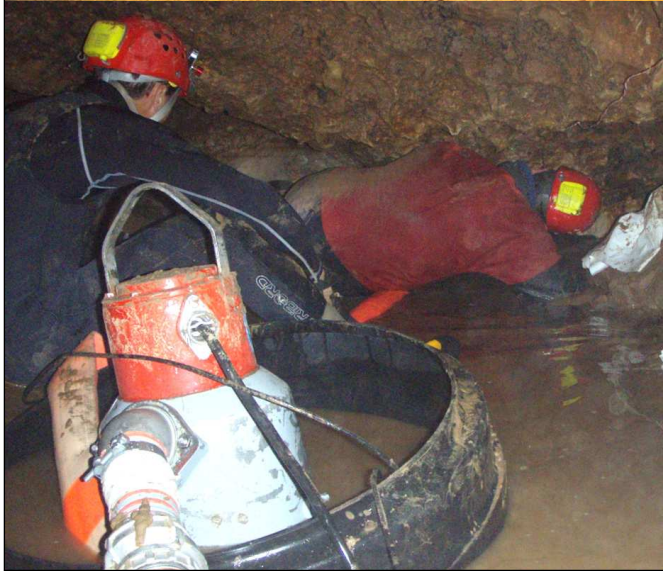
Photos du haut : acheminement des tuyaux dans la grotte et installation de la pompe au siphon 1
