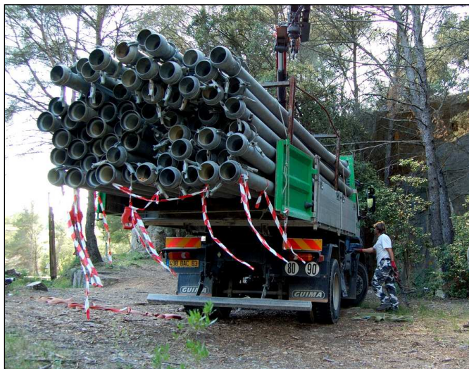
Le camion amenant les 450m de tuyaux nécessaires
