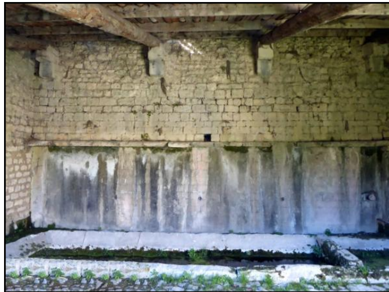
En haut : La toiture vue du dessous, on a réutilisé les soutiens des poutres de l'ancien toit de lauzes.
