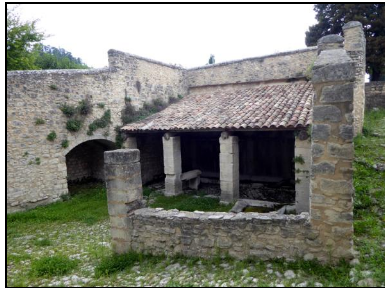
Lors de la restauration, un toit de tuiles a remplacé l'ancien toit de lauzes.
